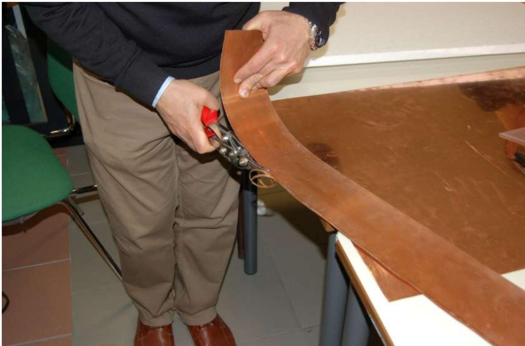
Taglio della lamiera in rame di raccordo delle due lastre.
