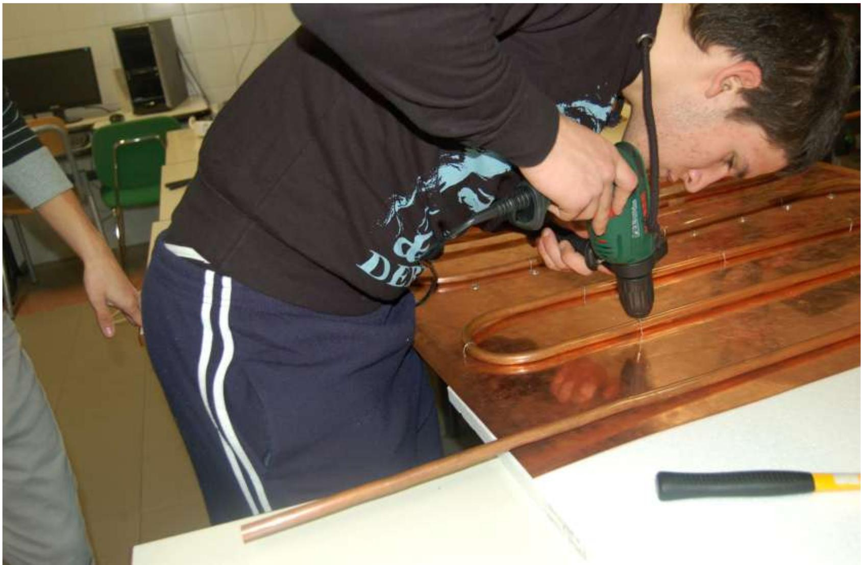
Foratura della lamiera per il passaggio del filo di ferro.
