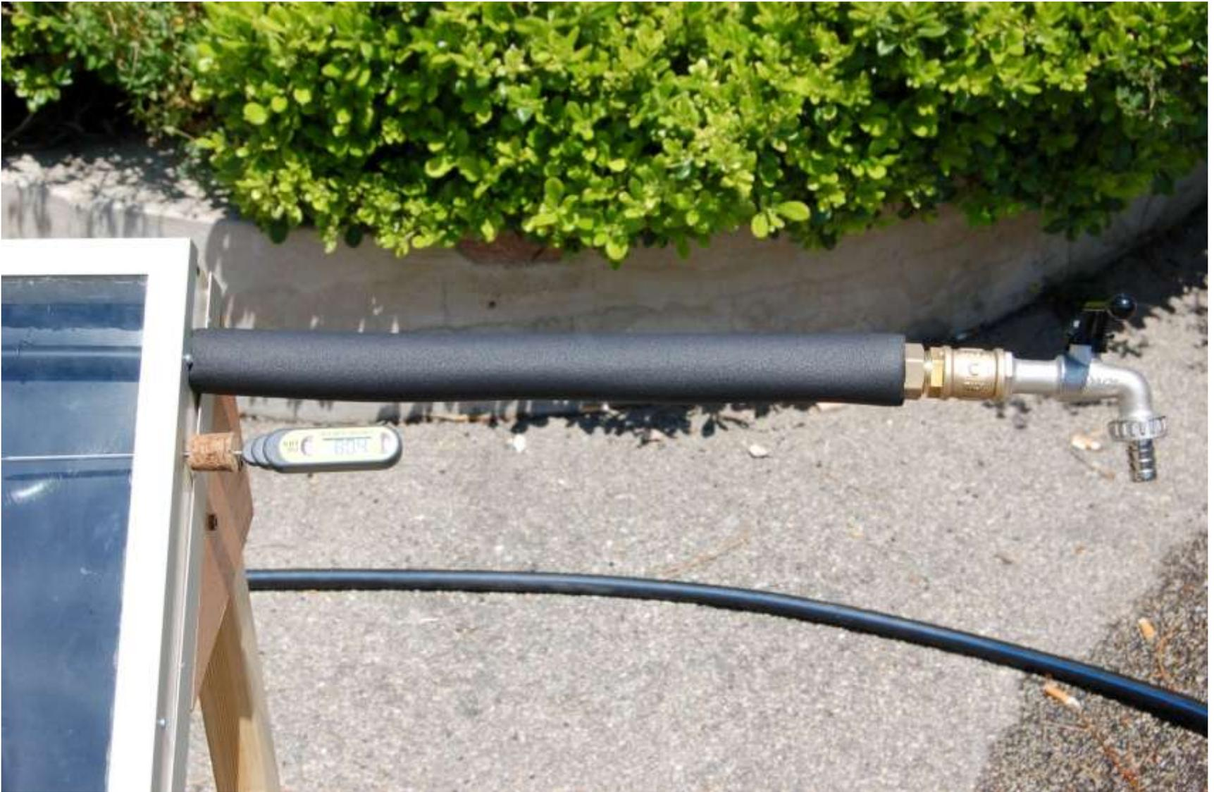
Rubinetto di uscita acqua calda e termometro per la misura della temperatura dell'aria all'interno del pannello (80 °C).
